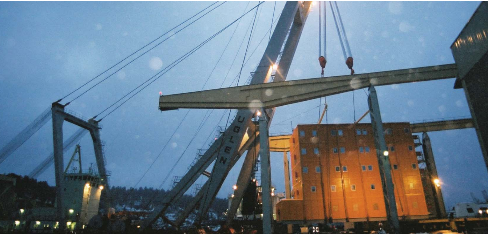
LOADOUT OF LB 4000 LQ (335 TONNES) BY «UGLEN» CRANE BARGE.
